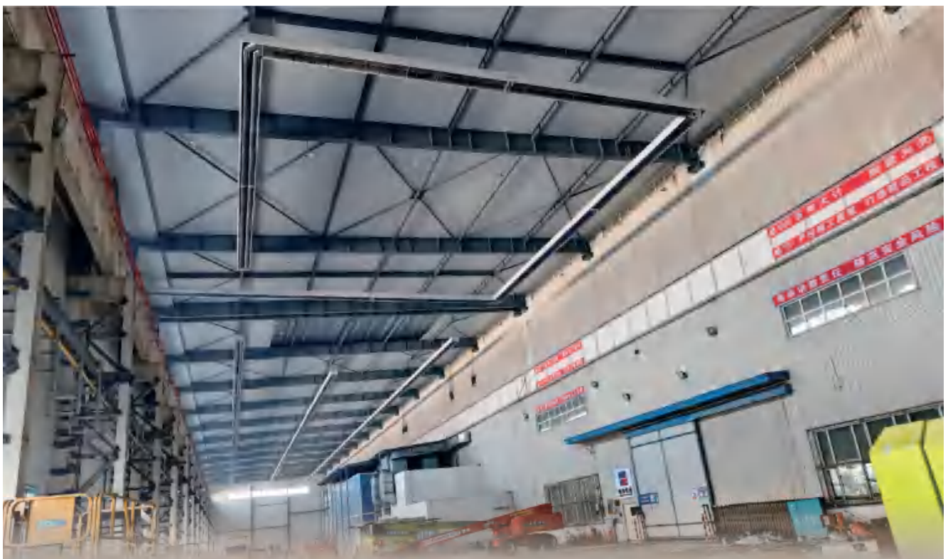
哈尔滨电力装备有限公司核电主泵电机厂房大管辐射-室内辐射带
