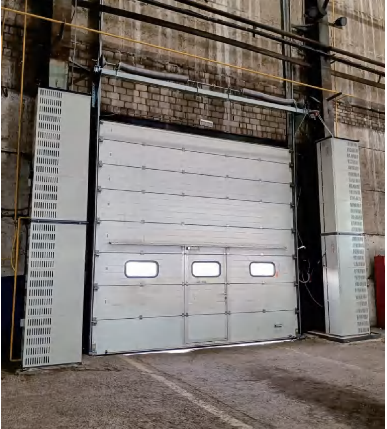
沈阳铁路局维修库
