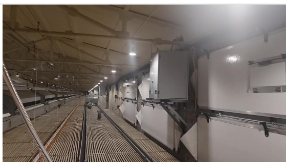
设备沿单边墙安装的实际场景
