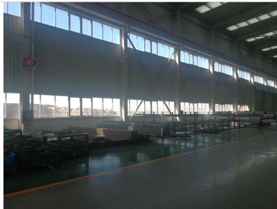
厂房侧墙区域及局部辐射供暖场景
