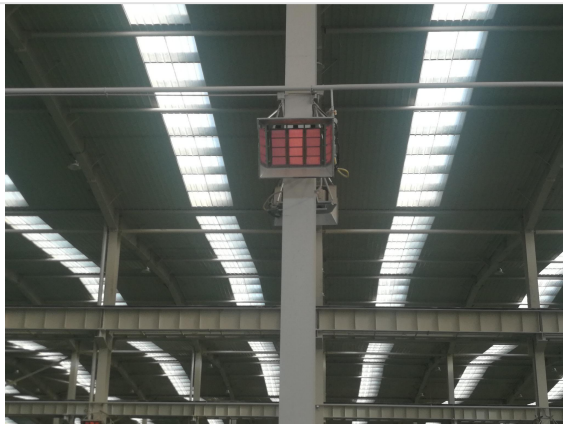
HTC09 高密度陶瓷板辐射加热器安装近景
