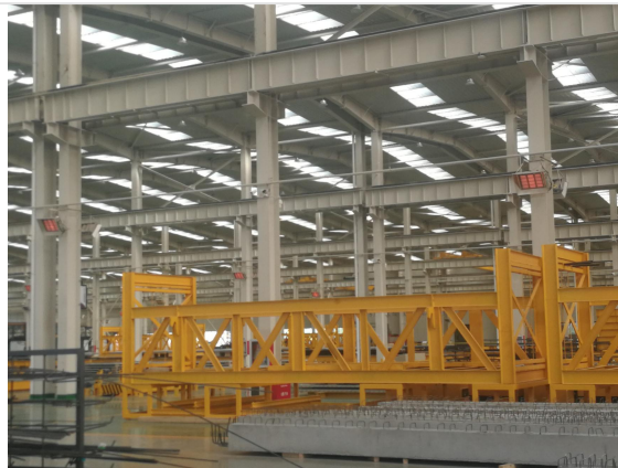
大空间厂房内多台设备布置场景
