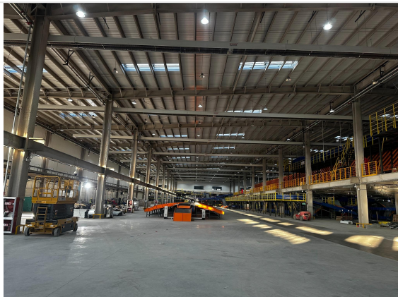
项目整体大空间内部场景
