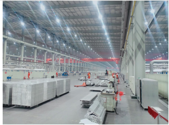
项目主车间整体大空间场景
