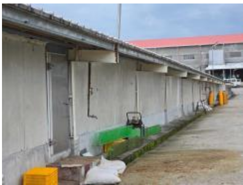
鸡舍外部整体场景及丙烷瓶组
