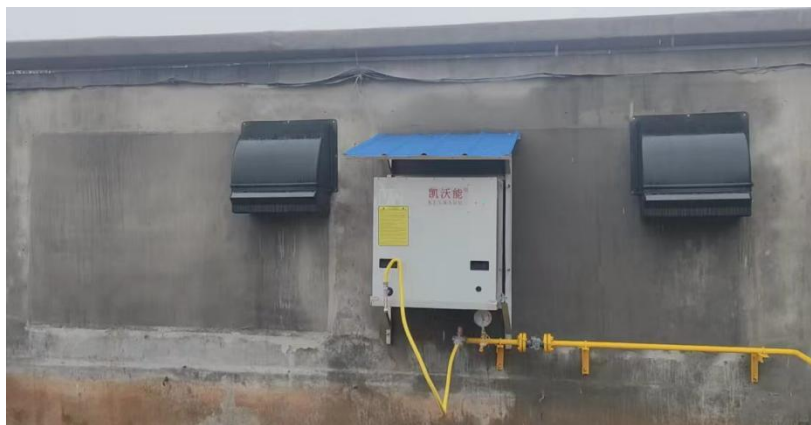
KWDHVS070设备安装
